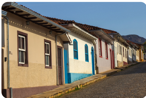
Casas geminadas com fachada na calçada, Mariana, Minas Gerais, 2023.
