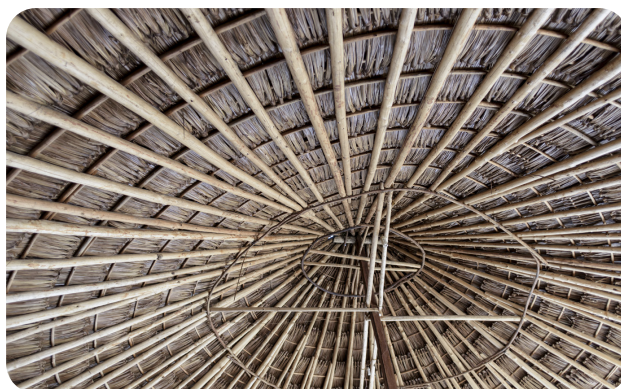
Telhado de palha de buriti, Terra Indígena Raposa Serra do Sol, Uiramutã, Roraima, 2017.
