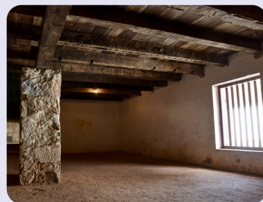
Vista interna da senzala em fazenda construída em 1817, São José do Barreiro, São Paulo, 2019.
